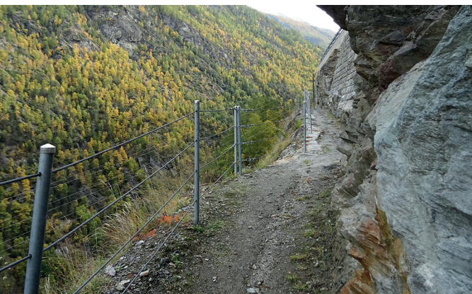
Le nouveau chemin, bien sécurisé dans la pente, passe sous la route cantonale. Photo: Sabine Joss
