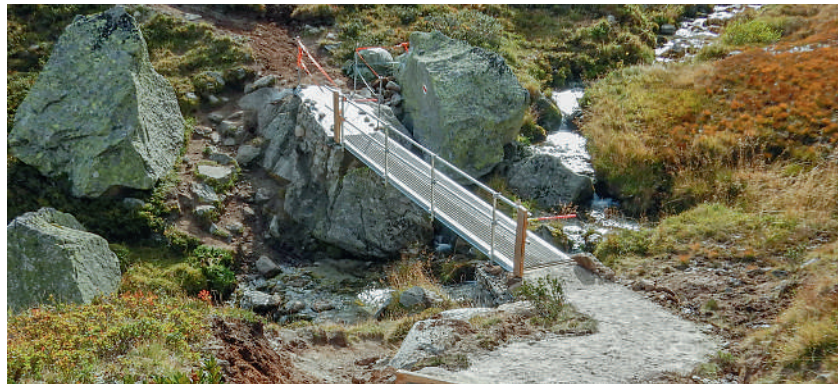
Abb. 73 Mit dem Mountainbike befahrbare mobile Brücke mit einseitigem Handlauf
