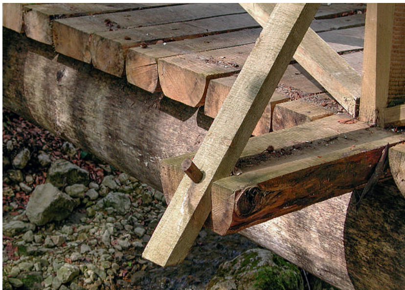
Abb. 69 Details des Haupttragwerks einer Holzbrücke
