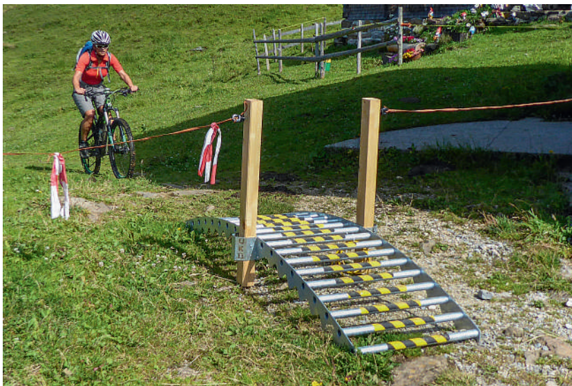
Abb. 94 Durchfahrbarer Zaundurchgang (Bogenrampe)
