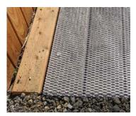
Abb. 71 Rutschfestigkeit der Gehfläche mit Streckmetall
