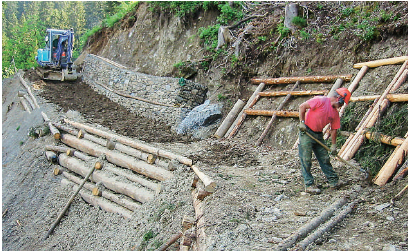
Abb. 104 Hangsicherung mit Holzkasten (links), Steinkörben (hinten) und Hangrost (rechts)
