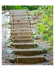
Abb. 79 Holztreppe mit Hinterfüllung
