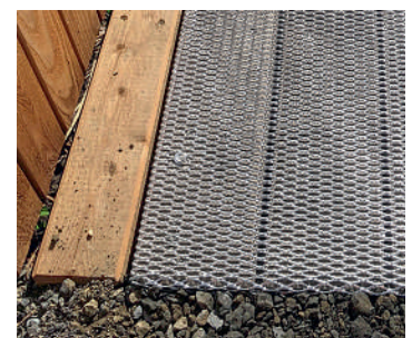
Abb. 71 Rutschfestigkeit der Gehfläche mit Streckmetall
