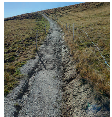
Abb. 28 Fortgeschrittene Längserosion
