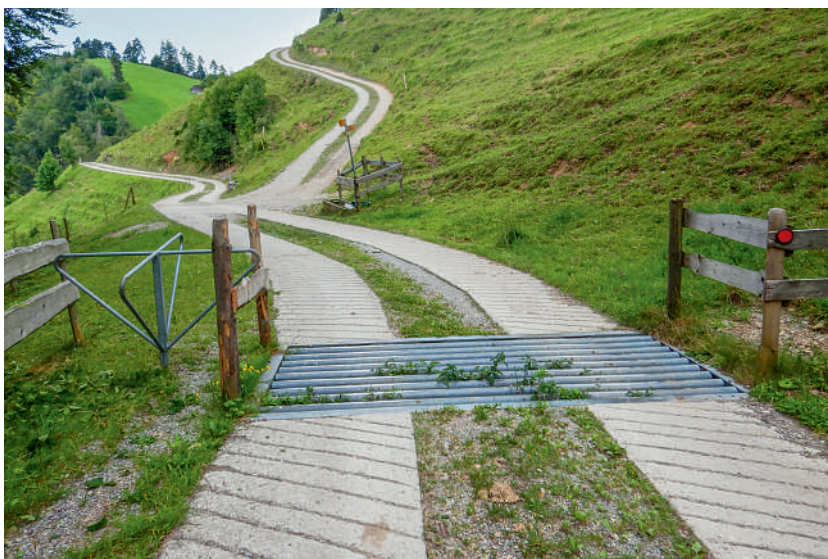
Abb. 95 Über einen Weiderost kann Landwirtschafts-, Forst- oder Individualverkehr den Zaundurchgang passieren.
