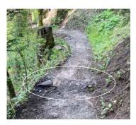
Abb. 53 Mit Steinen verstärkter Kieswall
