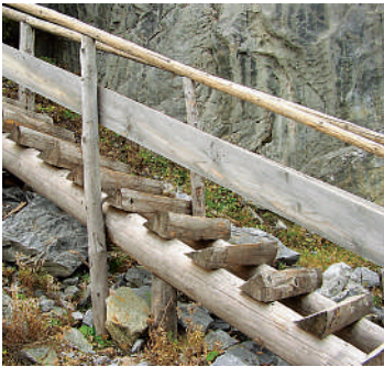
Abb. 83 Frei gespannte Holztreppe
