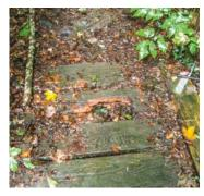
Abb. 111 Nasses Altlaub lässt Holzteile vermodern.
