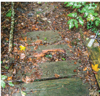
Abb. 111 Nasses Altlaub lässt Holzteile vermodern.
