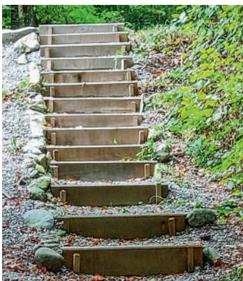
Abb. 79 Holztreppe mit Hinterfüllung
