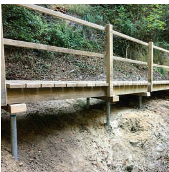
Abb. 68 Schraubfundamente sind eine Alternative zu massiven Widerlagern.
