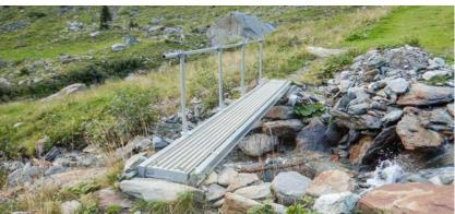
Mobile Brücken aus Aluminium eignen sich je nach Bauweise für die Überbrückung von Spannweiten bis maximal 10 Meter. Bei grösseren Spannweiten wird die Konstruktion für die Montage und Demontage von Hand zu schwer oder erfüllt die notwendige Tragfähigkeit nicht. Spezialanfertigungen werden beispielsweise von Unternehmen aus dem Gerüstbau hergestellt.
