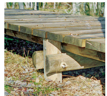
Abb. 76 Steg auf Pfeilern
