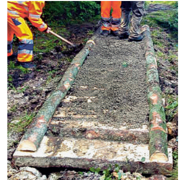
Abb. 19 Bedecken des Bohlenwegs mit Bodenmaterial und Schotter
