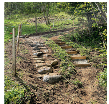
Abb. 27 Die kurzzeitige Trennung der Wegtrassen an unübersichtlichen Stellen bringt Sicherheit für die Wandernden.
