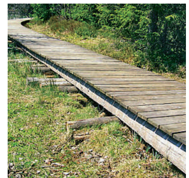
Abb. 77 Steg auf Querbalken
