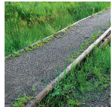
Abb. 20 Mit Schotter bedeckte Gehfläche eines Prügelweges. Die Beständigkeit von Prügel- und Bohlenwegen erhöht sich noch weiter, wenn das Holz auch seitlich mit Bodenmaterial eingepackt wird.
