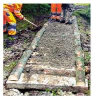
Abb. 19 Bedecken des Bohlenwegs mit Bodenmaterial und Schotter
