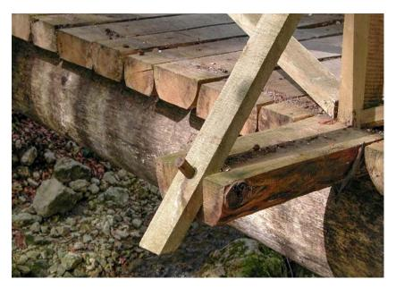
Abb. 69 Details des Haupttragwerks einer Holzbrücke
