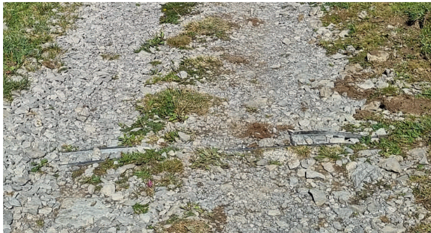
Abb. 51 Ist der Winkel zur Längsachse des Weges zu gering (weniger als 30 Grad), muss häufiger und rascher mit Verstopfungen gerechnet werden.
