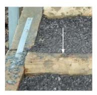
Abb. 81 Stufe mit Bohrlöchern für die Bewehrungsstahl-Stäbe (rutschbeständiges Kastanienholz)
