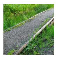
Abb. 20 Mit Schotter bedeckte Gehfläche eines Prügelweges. Die Beständigkeit von Prügel- und Bohlenwegen erhöht sich noch weiter, wenn das Holz auch seitlich mit Bodenmaterial eingepackt wird.
