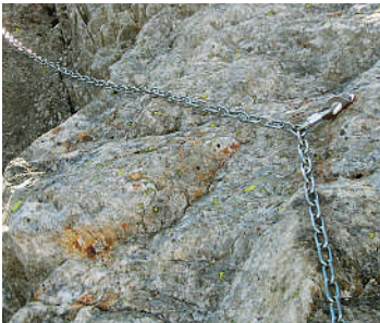
Abb. 90 Handlauf aus verzinkter Kette
