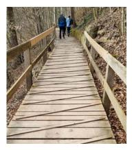
Abb. 70 Rutschfestigkeit der Gehfläche mittels schräg gestellter Hölzer
