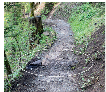
Abb. 53 Mit Steinen verstärkter Kieswall
