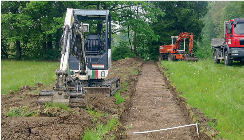
Abb. 22 Aushubarbeiten in ebenem Gelände
