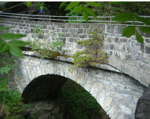
In der Nähe der Steinigen Brugg entspringt die Mineralquelle.
